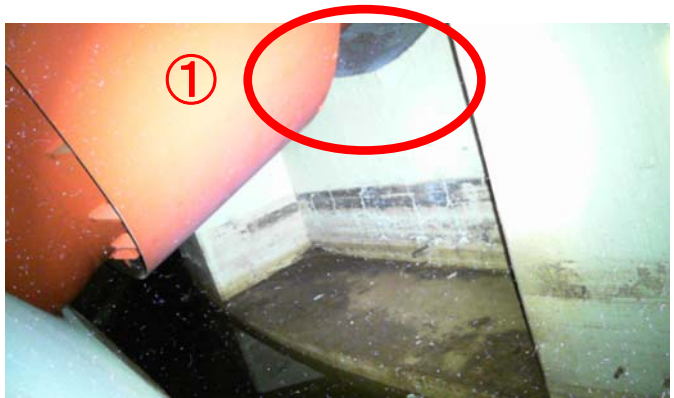
ベント管スリーブ端部
