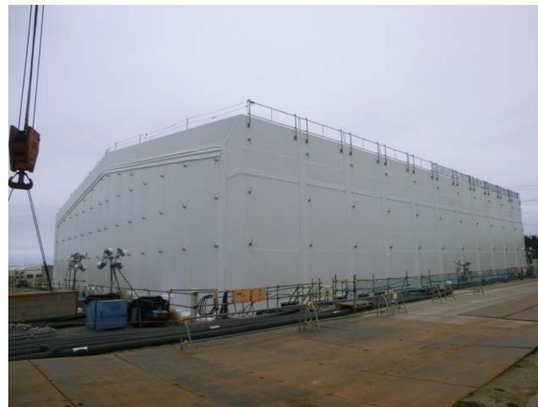
北東側より撮影
