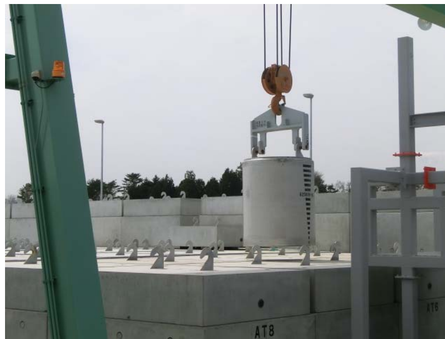
一時保管施設エリア
