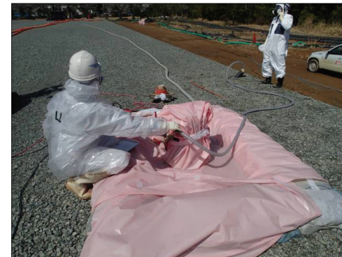
No. i 北東側拡散防止作業状況
