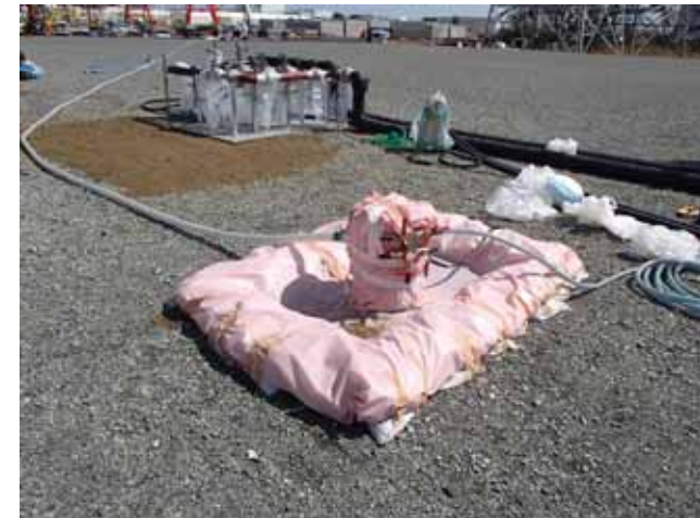
No. 貯水槽のポンプ設置状況(4/13撮影)
