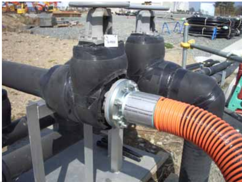
本設ライン～仮設ライン
