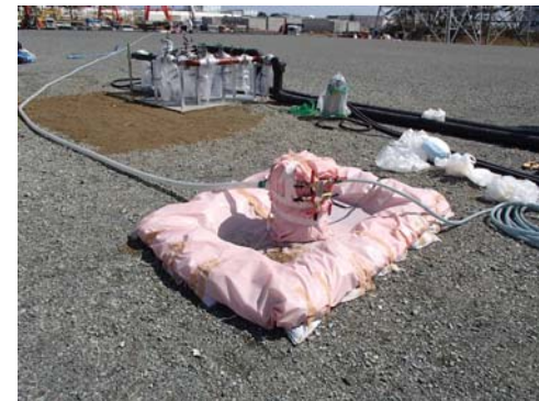
No.3貯水槽のポンプ設置状況(4/13撮影)
