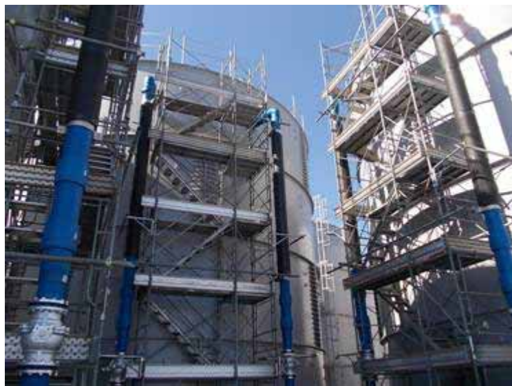
一時貯留タンク設置状況
