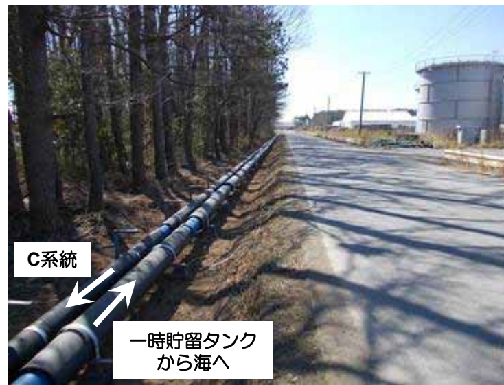
移送配管設置状況（C系統、一時貯留タンク～海）
