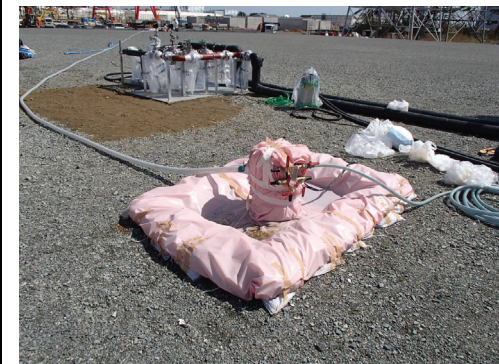
No.3貯水槽のポンプ設置状況(4/13撮影)
