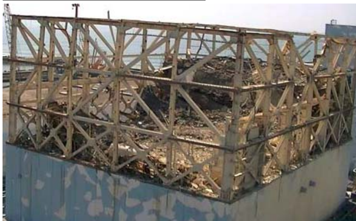
オペフロ全景 (北西面)
