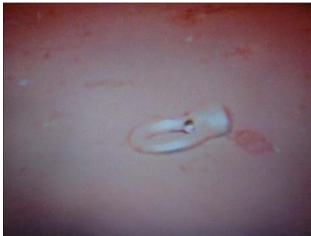
< 使用済燃料プール内における 異物の状況 > 平成25年5月23日撮影
