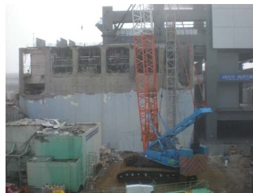
⑤ 西面（外壁）
