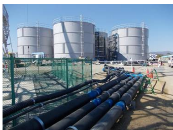
専用の配管・タンクを設置
