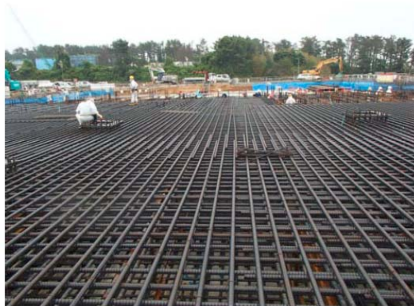
基礎の配筋状況
