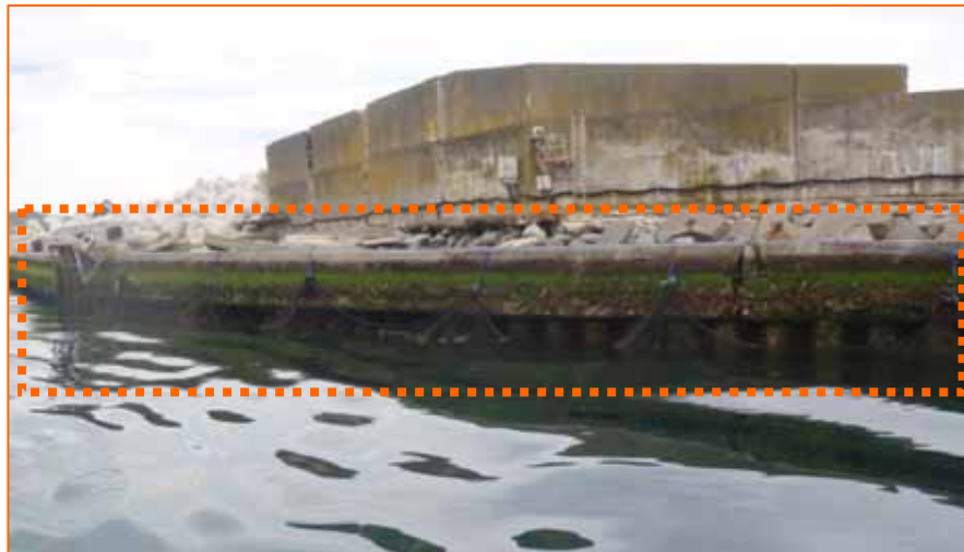
6/26 北防波堤付近に仕切り網設置済み
