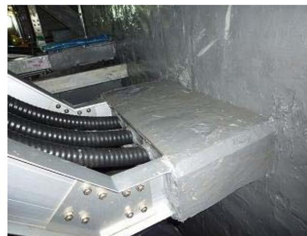
配管, ケーブル貫通部の止水処理施工例
