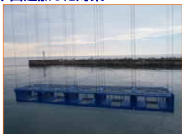
7/11 港湾口へのブロックフェンス設置済み (写真:ブロックフェンス設置作業状況)
