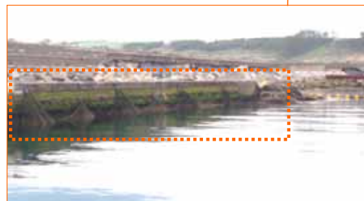
6/26 南防波堤付近に仕切り網設置済み
