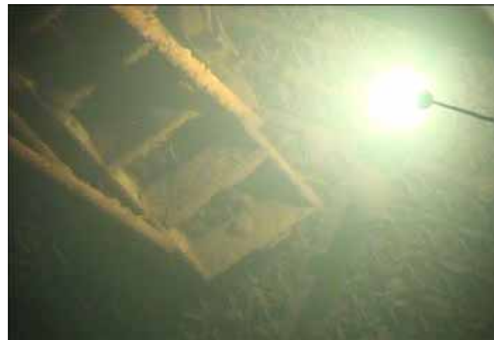
SFP内の作業台車梯子(ガレキ)
