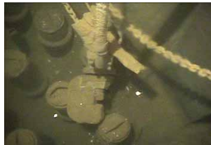
シュラウド取り替え工事関連機器
