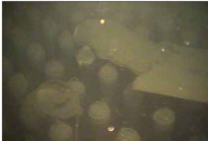
原子炉圧力容器底部のガレキ
