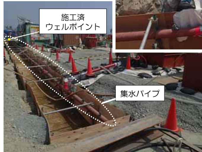
集水パイプの敷設状況 平成25年8月15日撮影 東京電力株式会社
