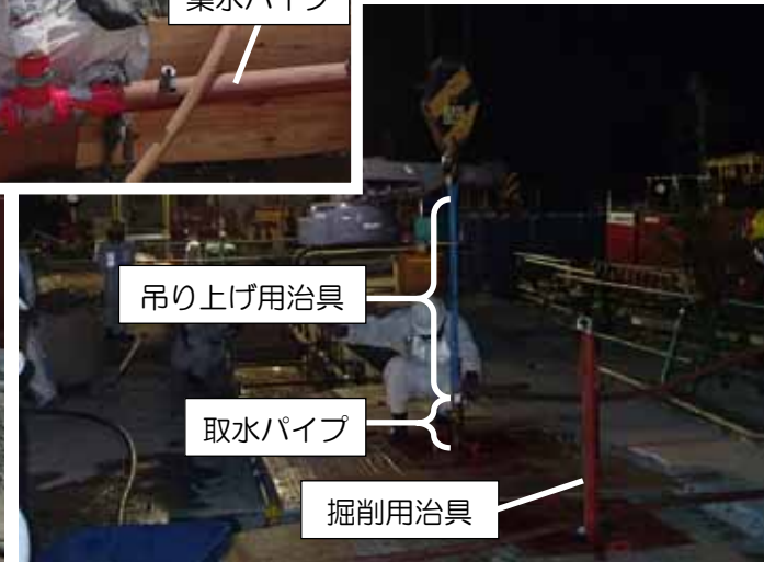
取水パイプ設置の様子 平成25年8月14日撮影 東京電力株式会社
