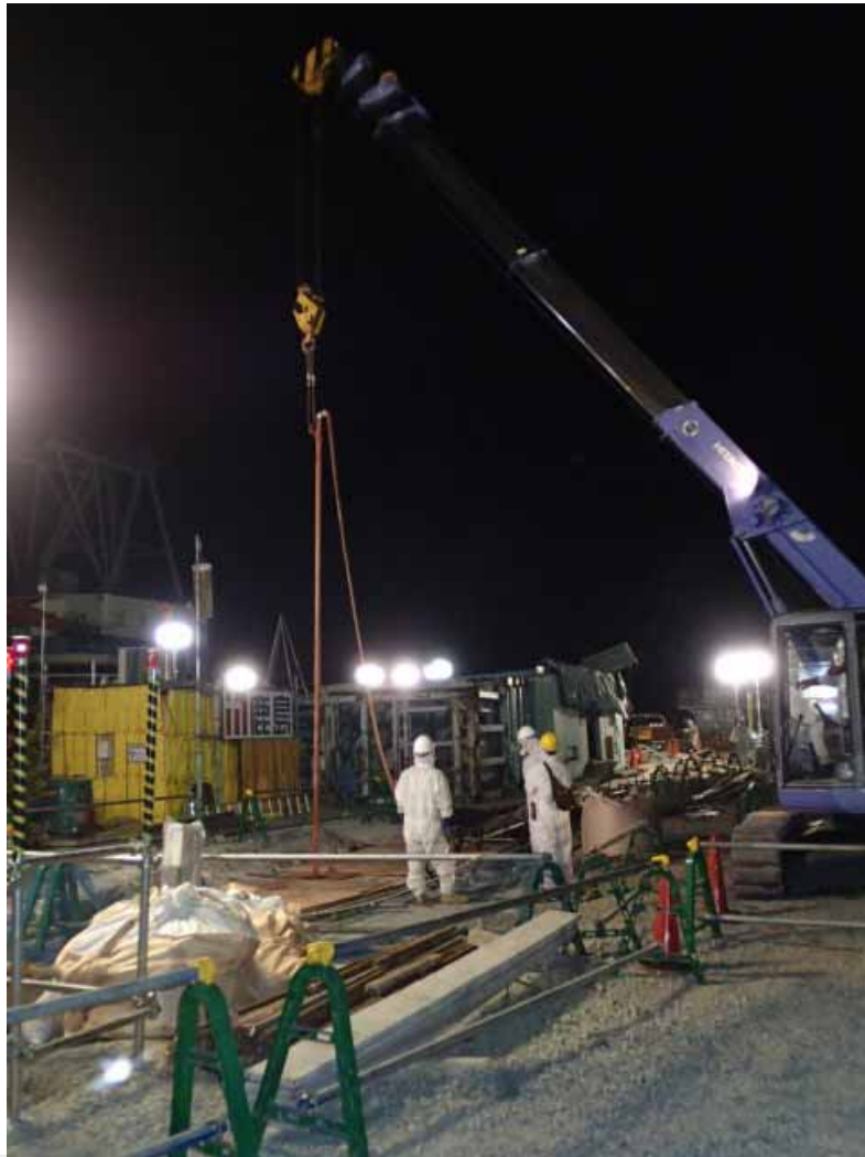
先行削孔の様子
