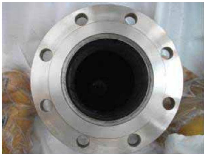
吸着塔 1 3 A 点検口フランジ部（ 腐食なし ）
