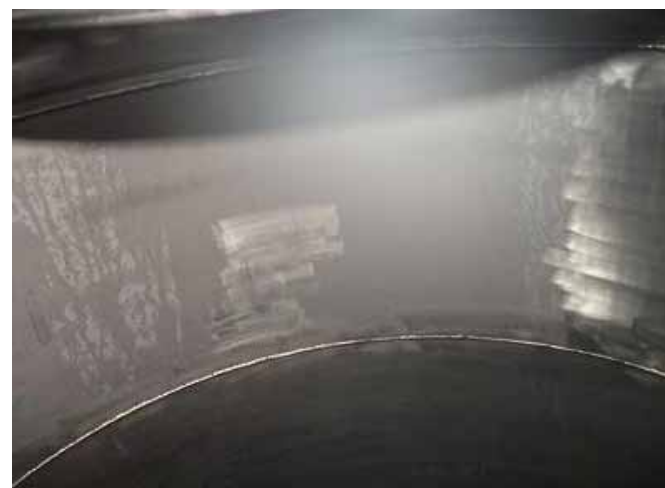
吸着塔 2 A タンク内上部溶接部（腐食なし）
