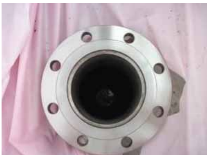
吸着塔 3 A 点検口フランジ部（腐食なし）
