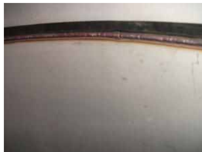
吸着塔 3 A タンク内上部溶接部（腐食なし）
