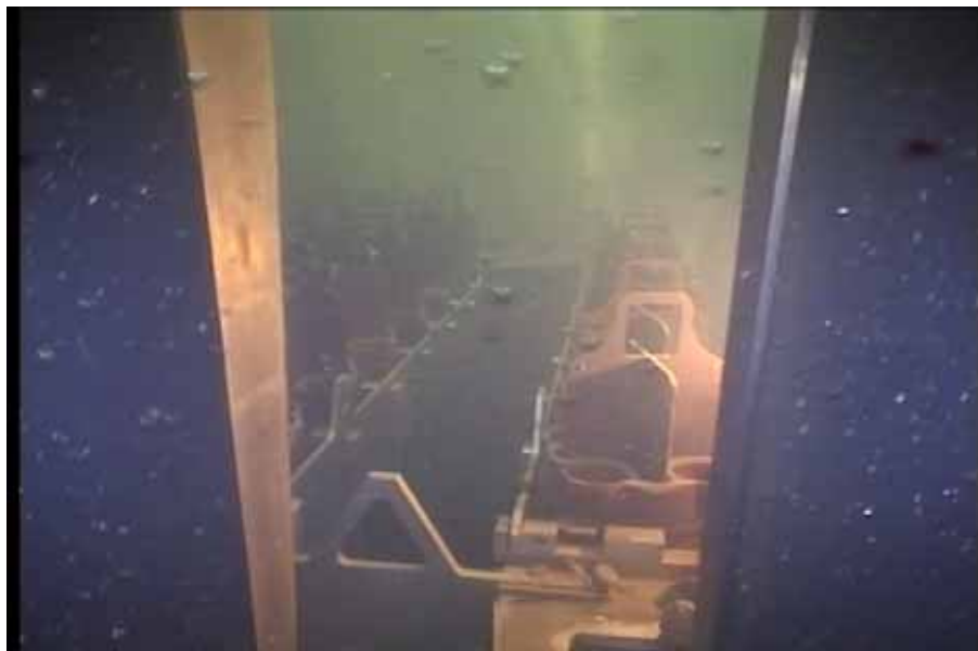
キャスクピット内を外側から撮影
