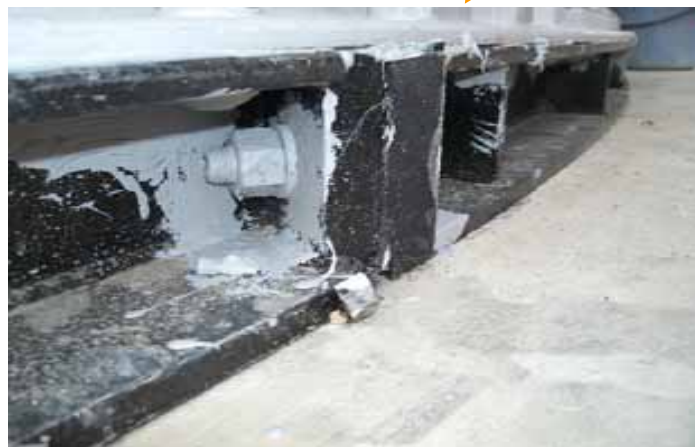
タンク底板フランジ接合部写真
