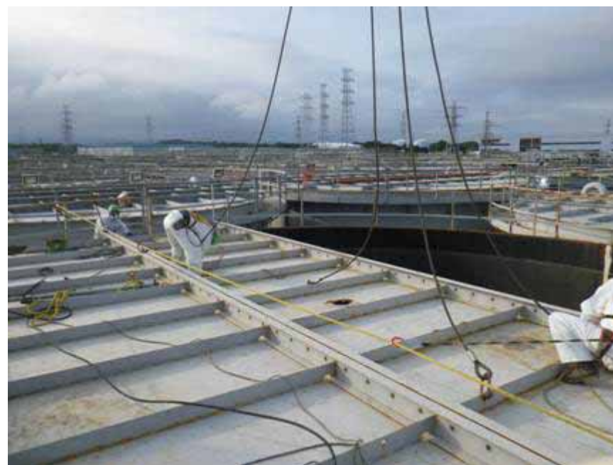
天板の取り外し作業
