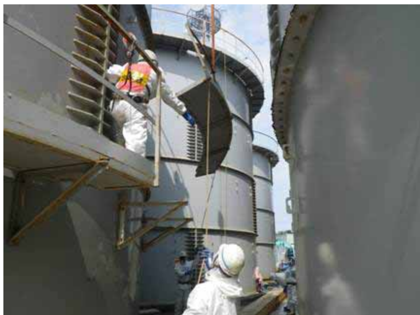
歩廊の設置作業
