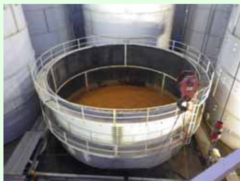
No.10 側板3段目撤去完了 (平成25年9月14日撮影)
