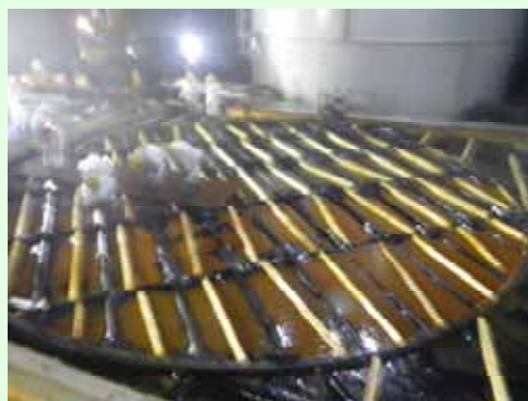
No.10 側板1段目撤去完了 (平成25年9月16日撮影)
