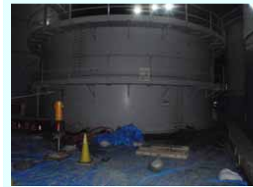
No.5 側板3段目撤去完了 (平成25年9月18日撮影)
