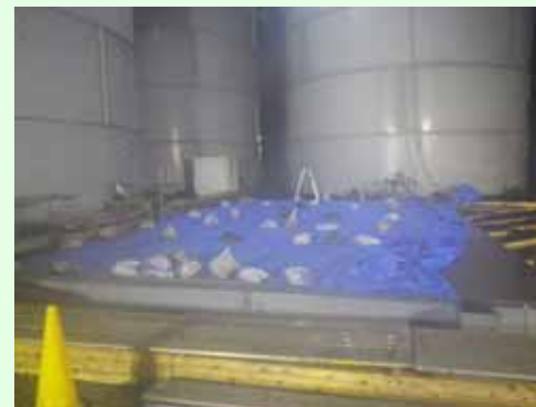
No.10 底板補強完了 (平成25年9月16日撮影)
