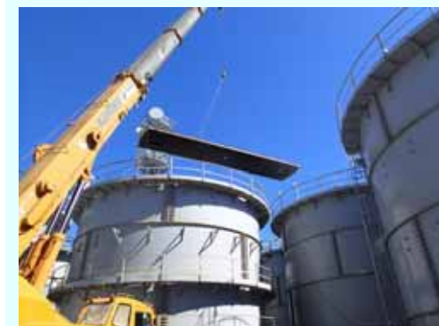
No.5 天板撤去作業 (平成25年9月17日撮影)
