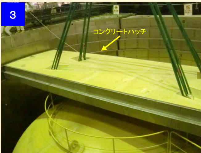
コンクリートハッチの取り外しの様子 (平成25年9月17日撮影)
