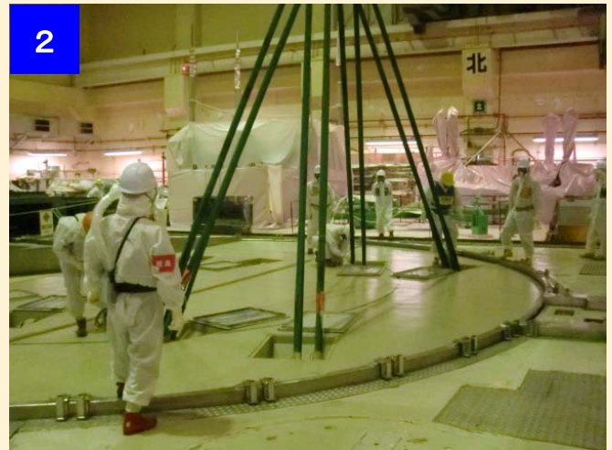
コンクリートハッチの取り外しの様子 (平成25年9月17日撮影)
