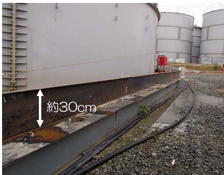
写真-1 応急堰の設置状況(H4北エリア)
