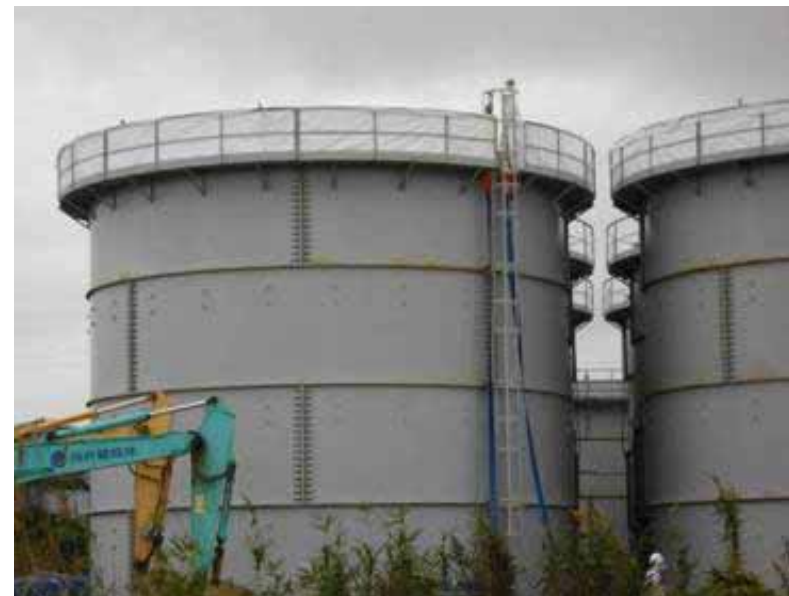
No12タンク全景
