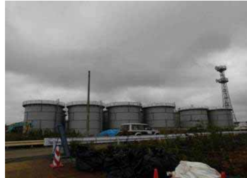
H4エリア東側全景
