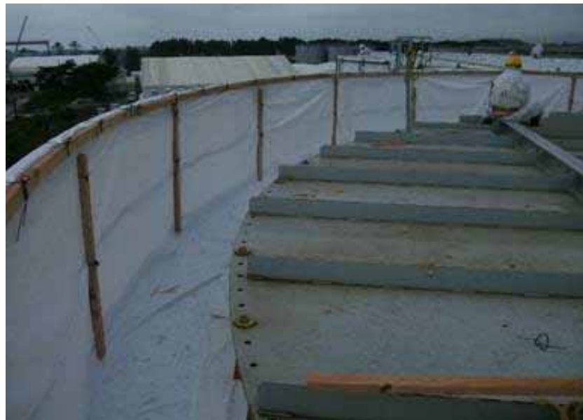
No3タンク歩廊部
