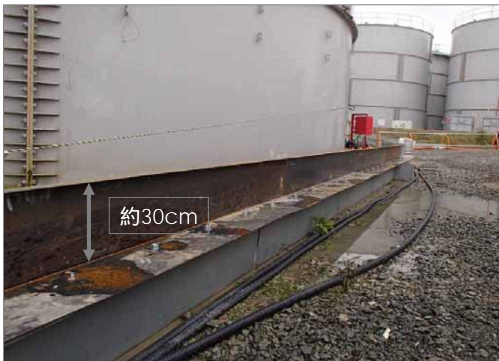
鋼製板による堰の設置状況(H4北エリア)
