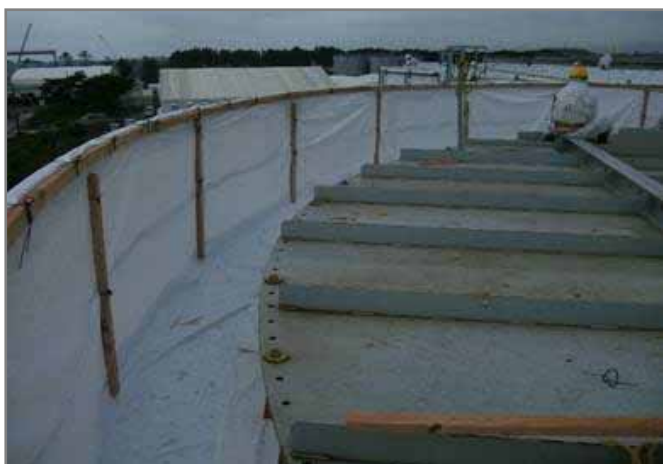
タンク歩廊部
