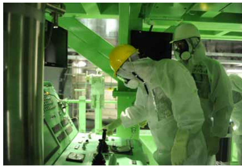
4号機燃料取扱機の視察状況
