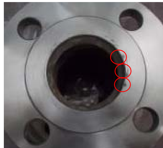
⑦供給ポンプ1出口配管フランジ
