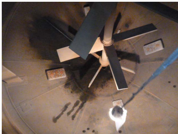
①バッチ処理タンク2C
