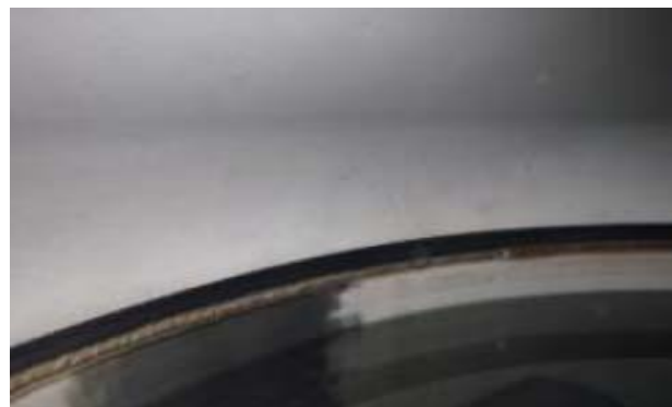
⑩吸着塔7C内部溶接線
