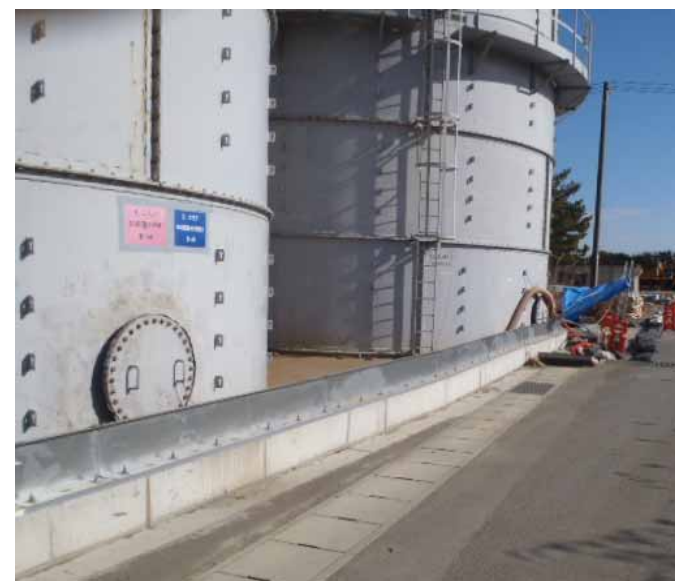
B南タンクエリア堰嵩上げ状況
