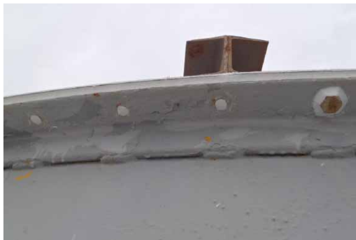
B南タンクエリアの天板部コーキング処理状況
