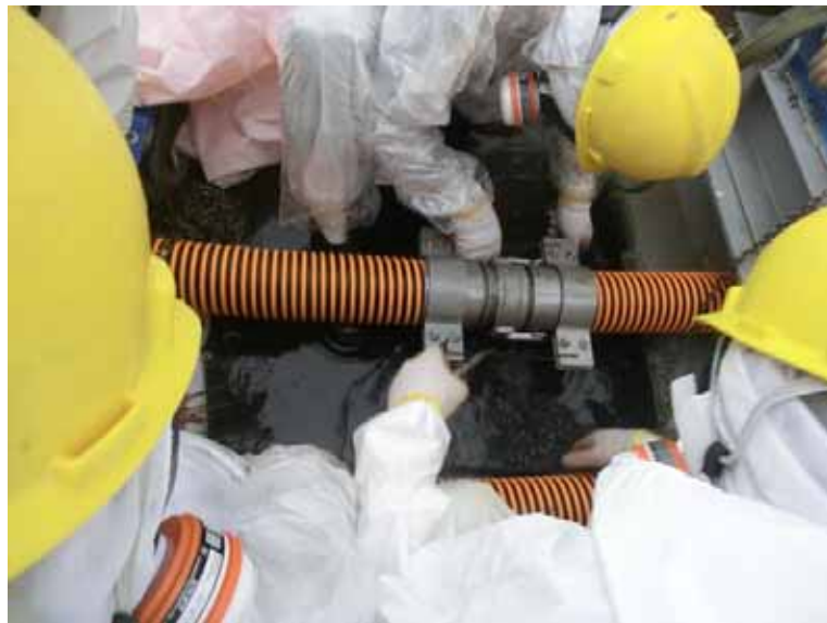
耐圧ホース接続部の状況
