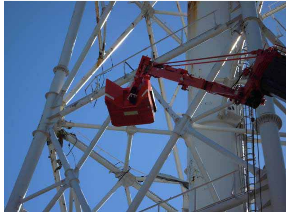
クレーンかごに測定器を設置
