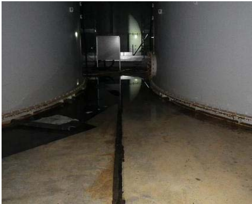
コンクリート打継ぎ部の状況（H4東エリア）
