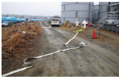
タンク堰内の漏えい水の移送準備
