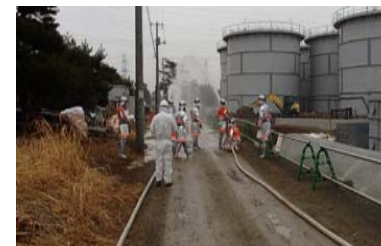
現場での消火活動
