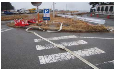
注水の準備（道路横断部のホース敷設）
