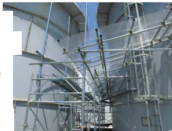
施工後の様子
