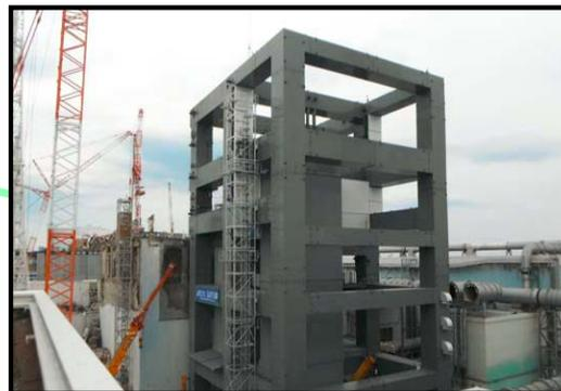
③原子炉建屋上部を除く鉄骨建方完了
