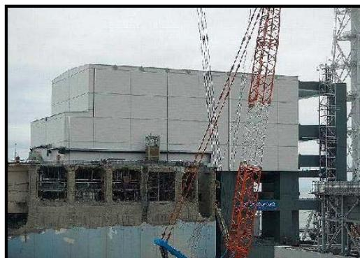
⑦外壁・屋根パネル設置完了
