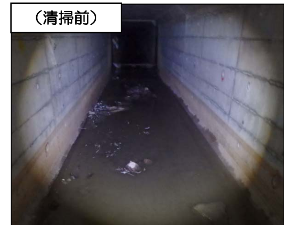
【写真③】K排水路内部
