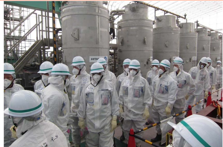
高性能多核種除去設備
