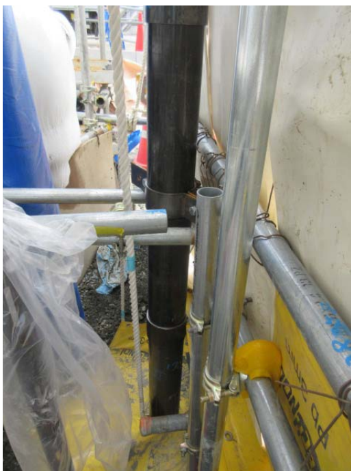
立坑D充填孔付近の様子
