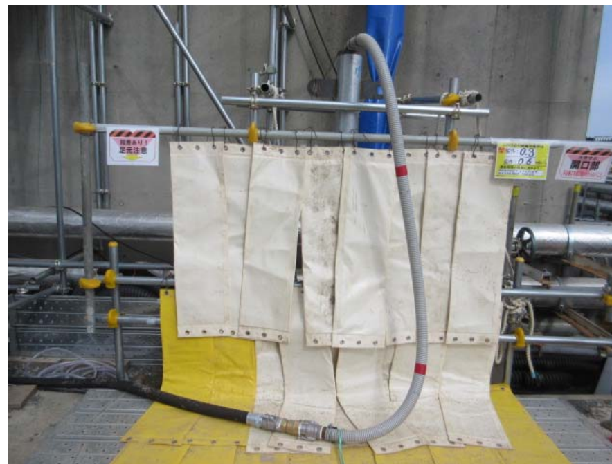
立坑D閉塞充填作業の様子
