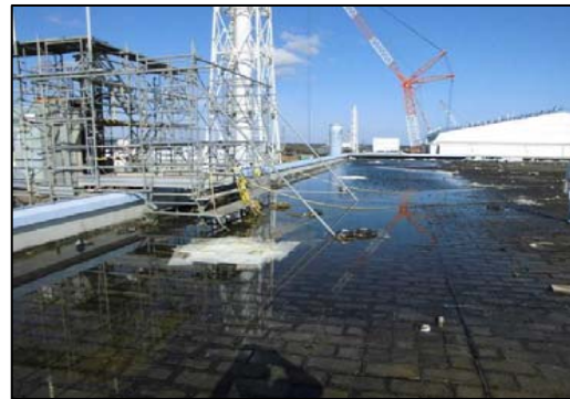
写真②：2号R/B屋上
