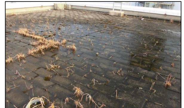
写真④：大物搬入口屋上
