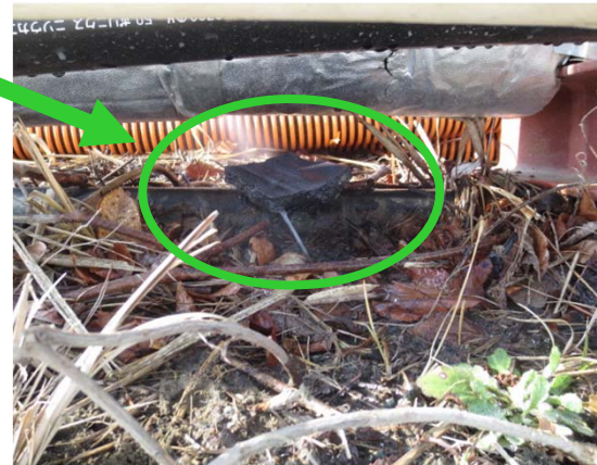
現場状況（北西土手）
