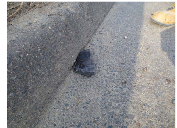
現場状況（路上③）
