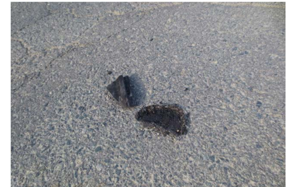
現場状況（路上②）
