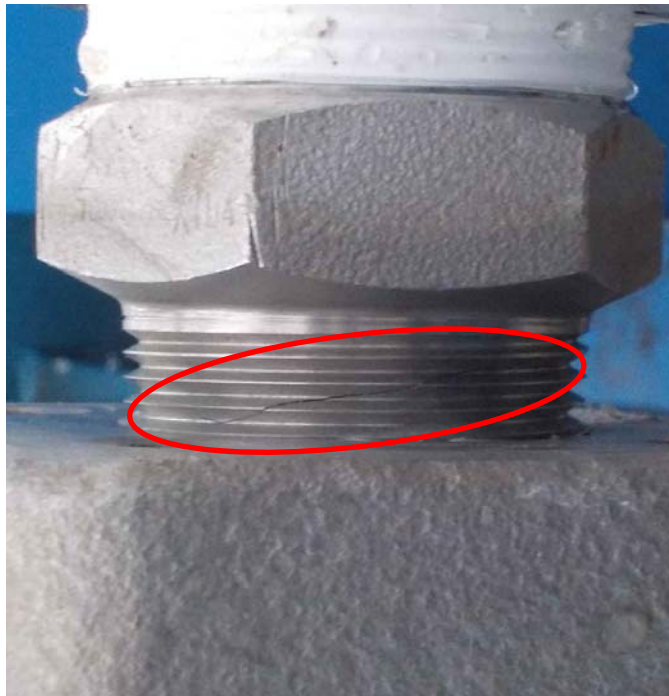
継手(ニップル)ネジ部の割れ
