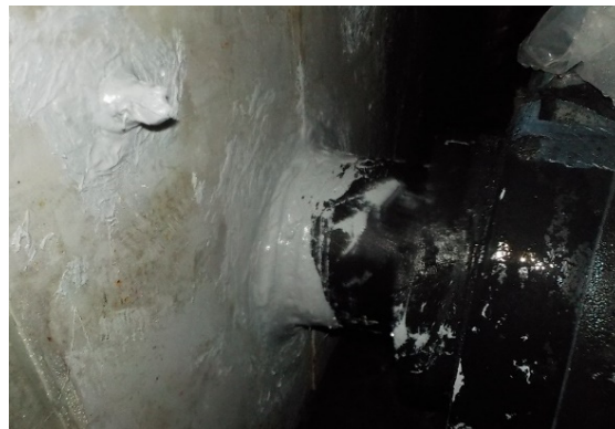
止水措置実施状況
