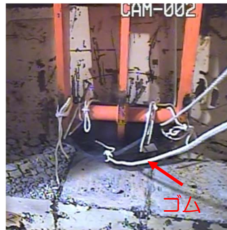
背面鉄板引抜状況
