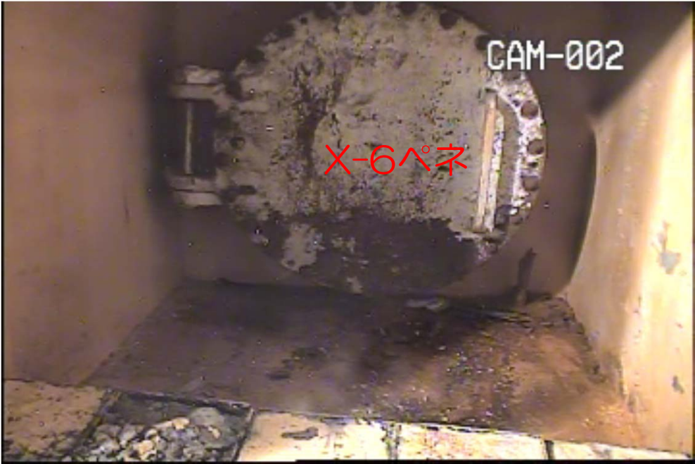
背面鉄板撤去後
