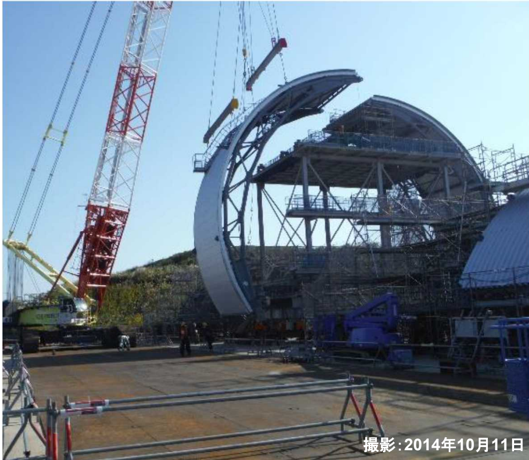
屋根部材の組立状況
