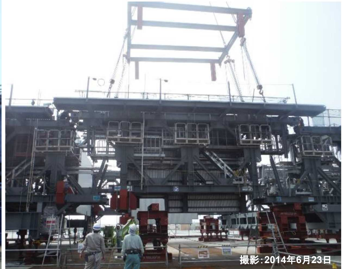
ガーダの組立状況
