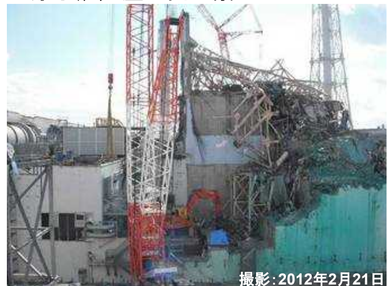
■原子炉建屋北面全景
