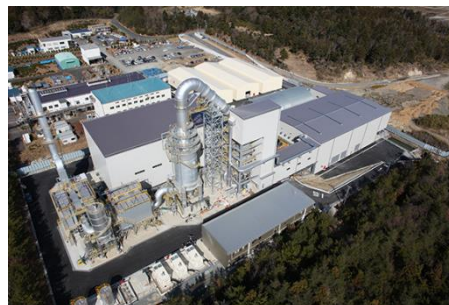
仮設焼却炉(屋外設置)*1
