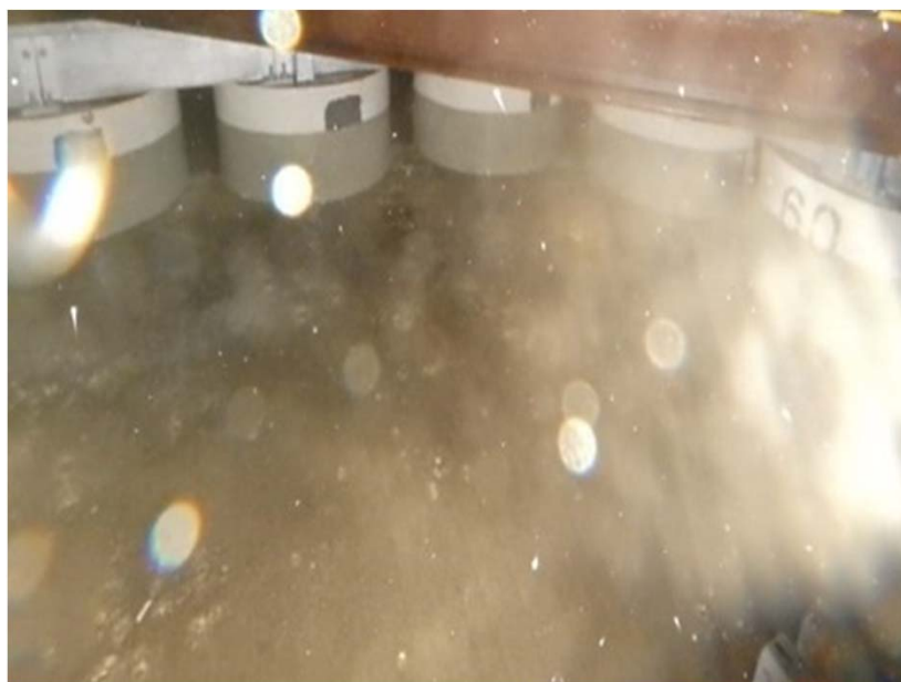
海側遮水壁北側に変状なし
