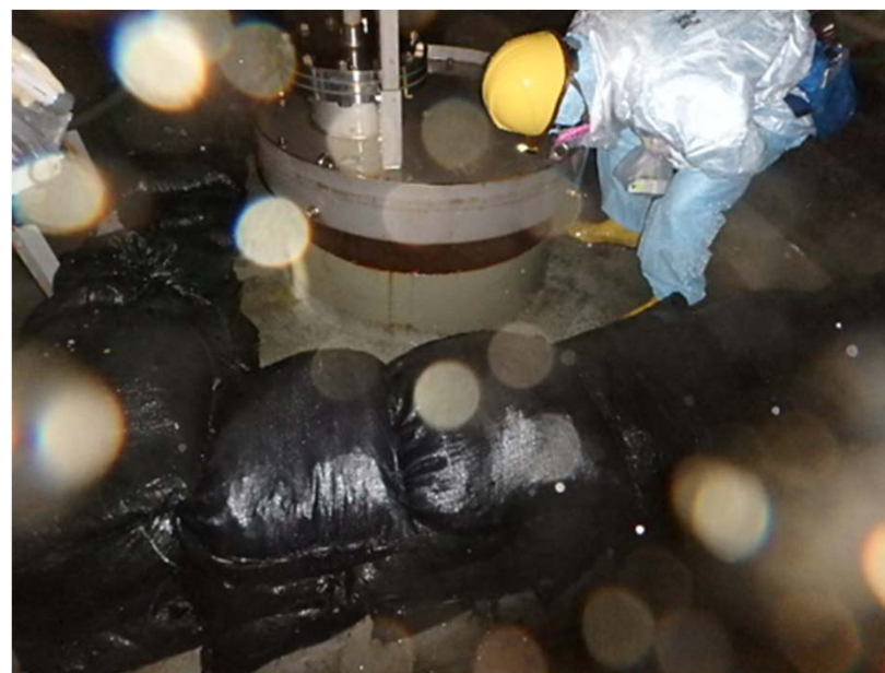
地下水ドレン観測井Bの状況 湧水なし
