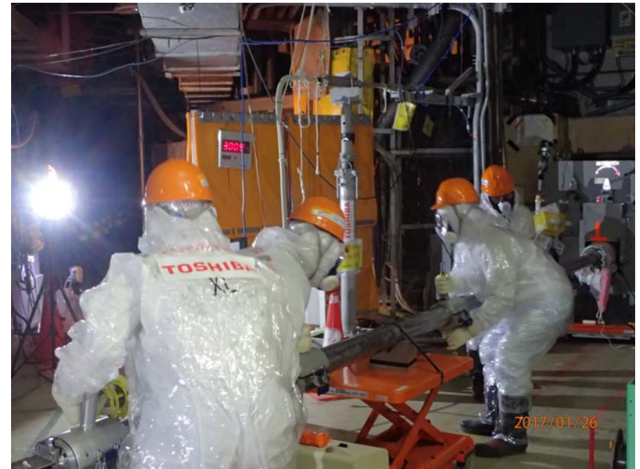
【2号機原子炉建屋内】
