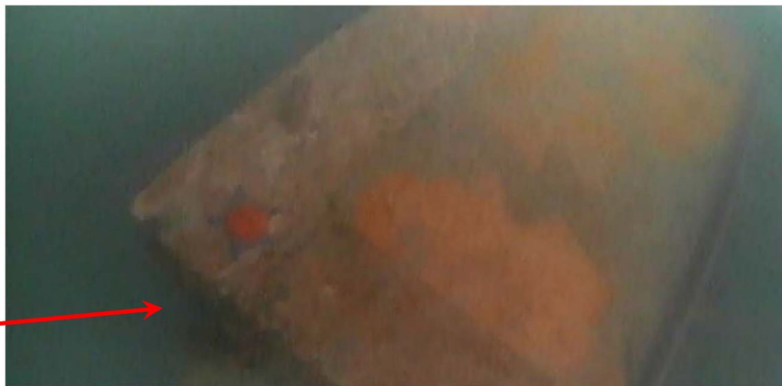
海中のブロックフェンス(底面部が水面方向を向いている)
